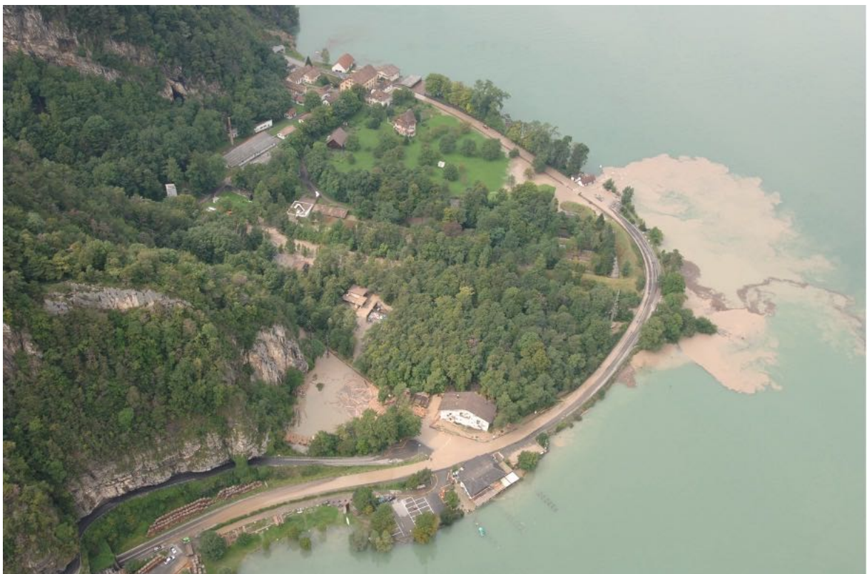
Abbildung 56: Luftbild der Isleten nach der Überschwemmung 2005. Das Bild wurde mit Blick nach Norden aufgenommen. Man erkennt, dass vor allem der südliche Teil des Deltas stark überschwemmt wurde. Quelle: (Amt für Tiefbau - Kanton Uri, 2005)
