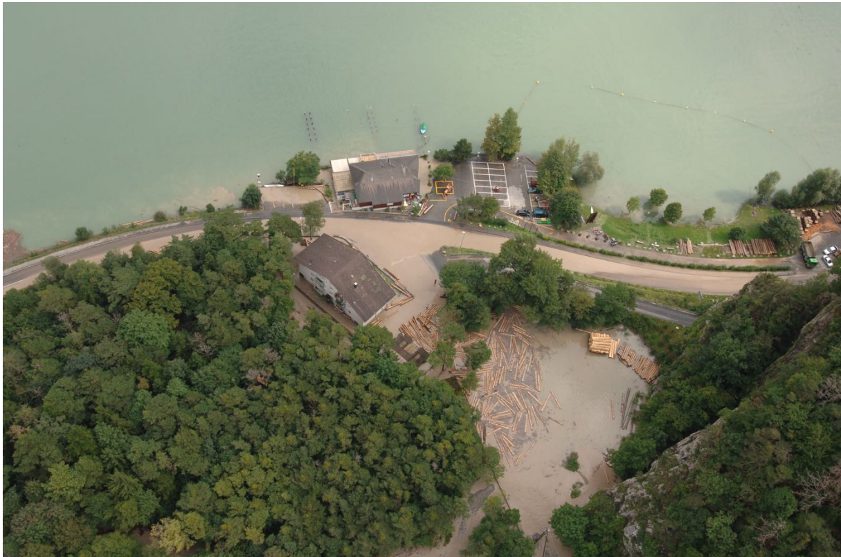
Abbildung 55: Luftbild der Isleten nach der Überschwemmung 2005. Man erkennt den überschwemmten Parkplatz mit dem Schwemmholz rechts vom Wohnhaus. Am Seeufer erkennt man das Restaurant. Quelle: (Amt für Tiefbau - Kanton Uri, 2005)
