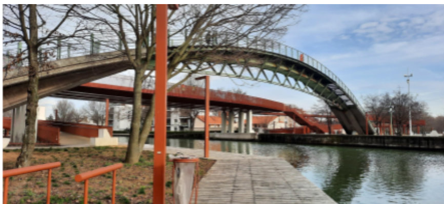
Fig. 10: The new Passerelle Lucie-Bréard linking Franc-Moisin and the Stade de France (Author, 2025)
