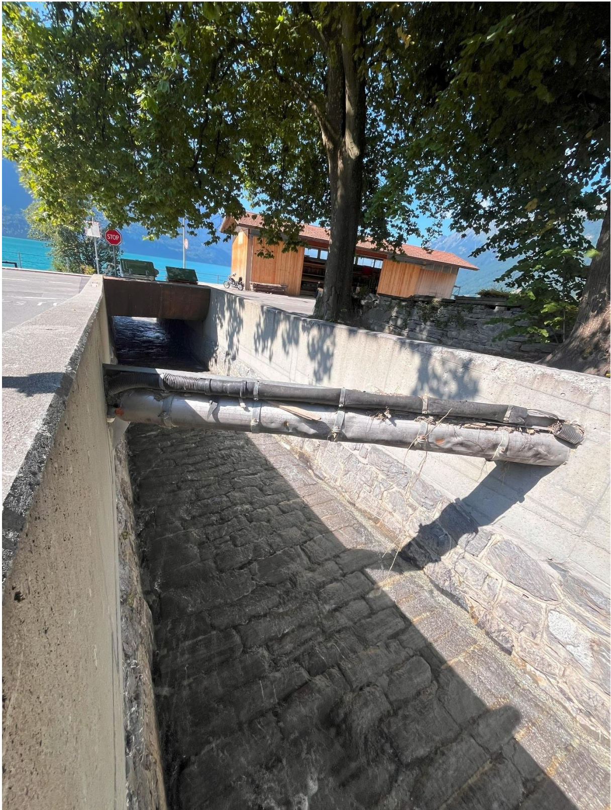
Figure A 12 Das Flussbett des Milibachs im Dorf kurz vor der Mündung in den See.
