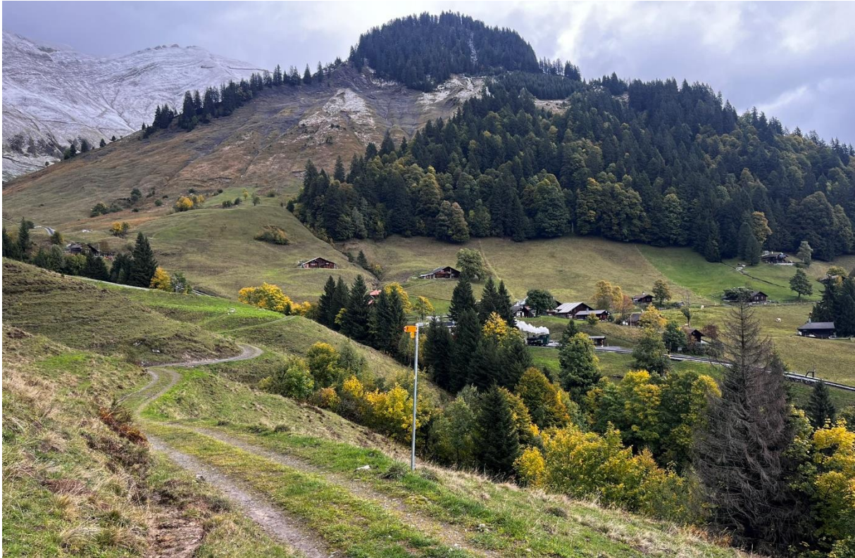
Figure A 21 Die Runsen oberhalb des Milibachs laufen grösstenteils über das anstehende Grundgestein.
