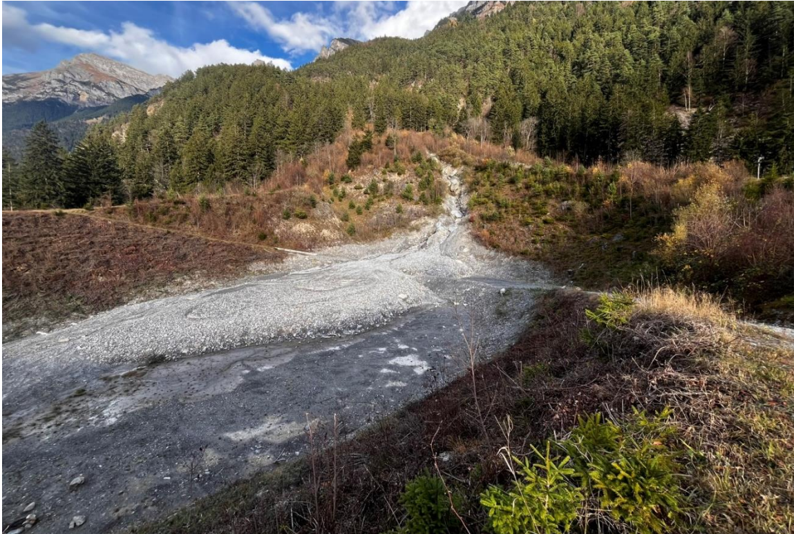
Figure A 43 Einlauf in den Geschiebesammler des Schipfenbachs. Zum Zeitpunkt der Begehung waren Ablagerungen von ca. 1m im Sammler von einem kleinen Ereignis vorhanden.
