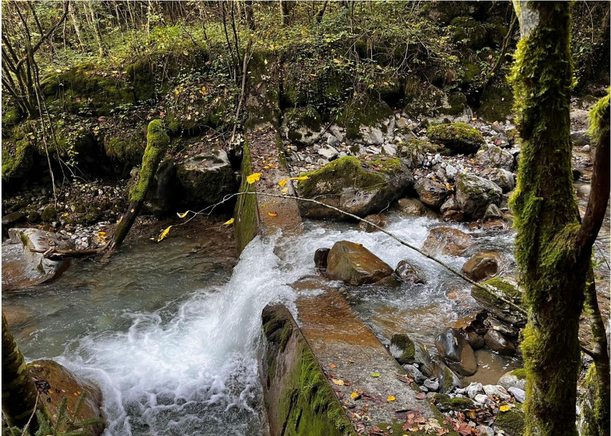
Figure A 31 Schwelle im untersten Bereich des Buoholzbachs ob dem Ablagerungskegel.
