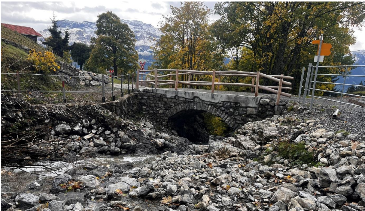
Figure A 24 Brücke neben der BRB-Station Planalp frisch repariert.
