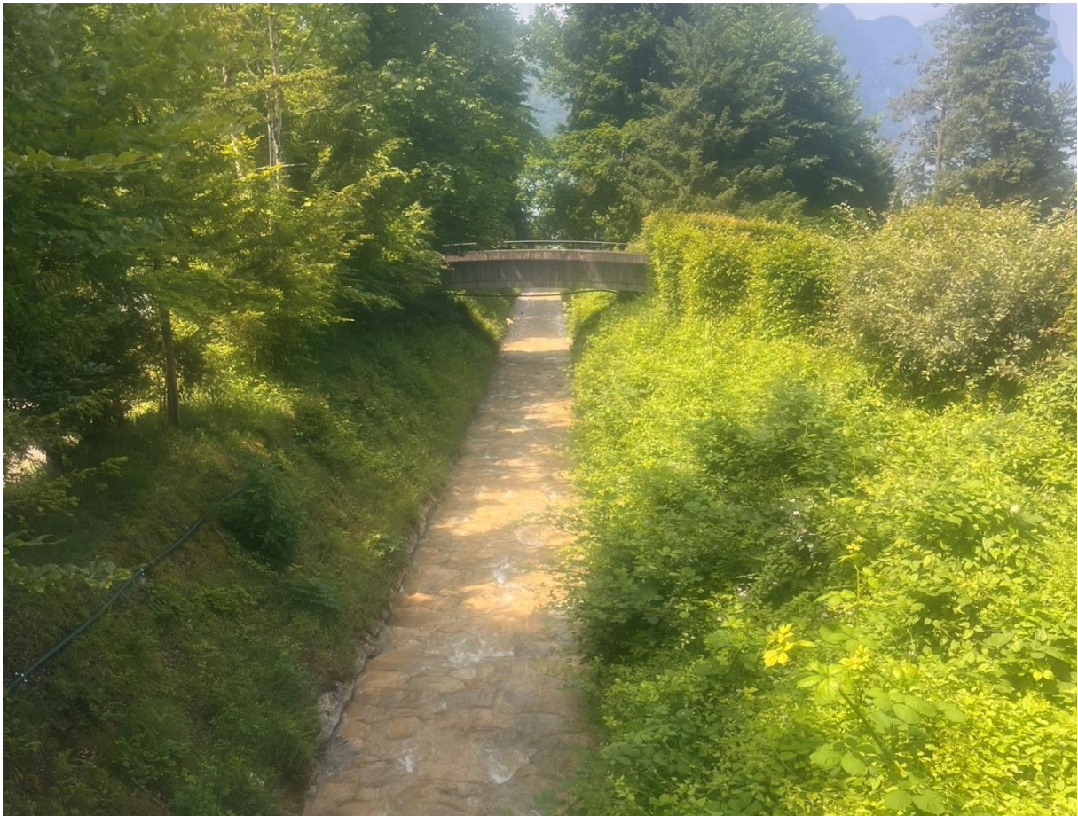
Figure A 7 Bachbett des Altdorfbachs im untersten Teil durch Vitznau.
