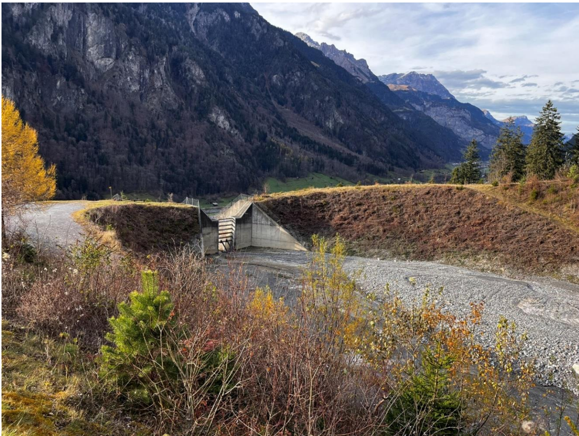
Figure A 42 Geschiebesammler und Abschlussbauwerk am Schipfenbach.
