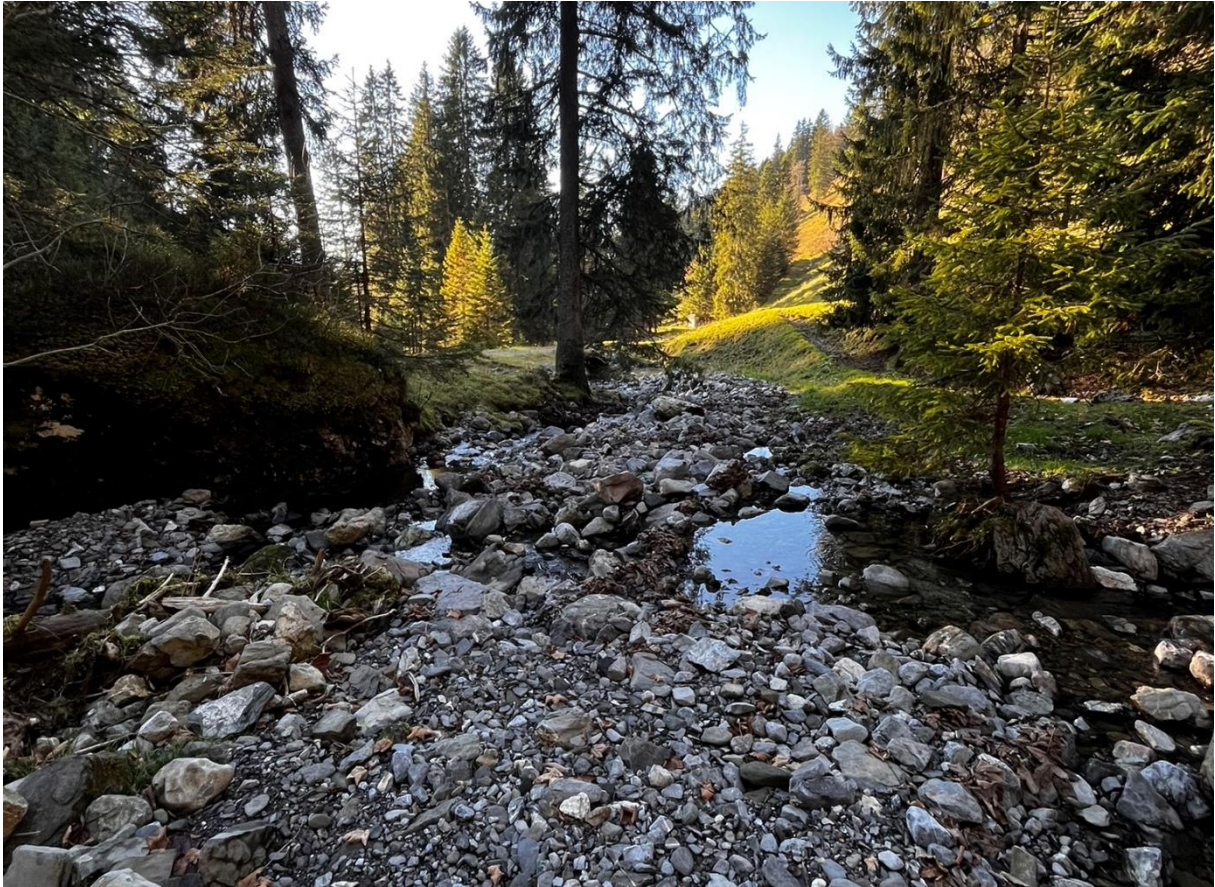
Figure A 35 Ablagerungen im Bereich Brändlisboden.
