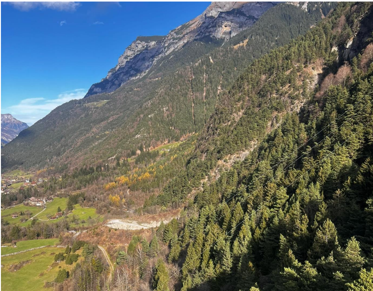
Figure A 44 Steiler Mittellauf des Selderbach und Geschiebesammler.
