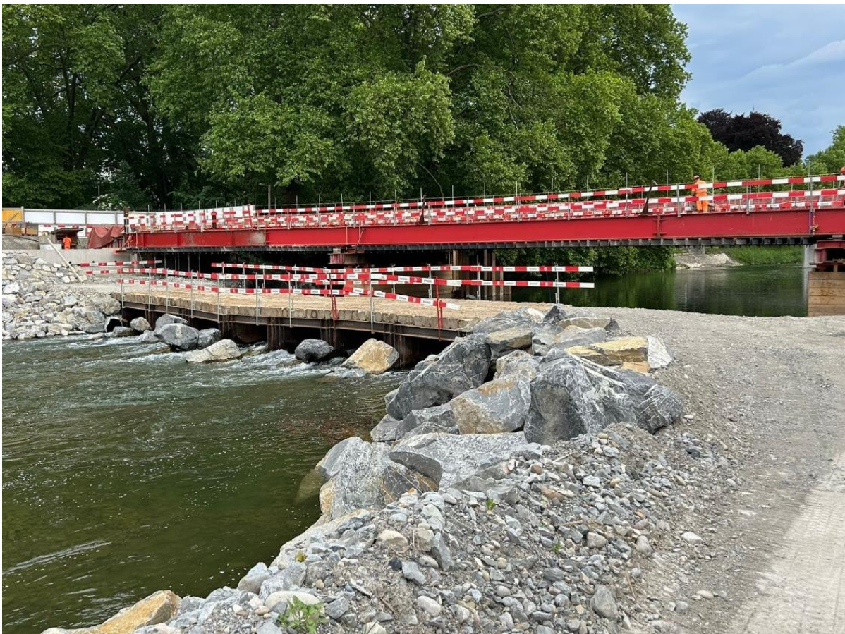
Abbildung 3: Provisorische Brücke für Baufahrzeuge, sowie Kiesbänke für Zufahrt.
