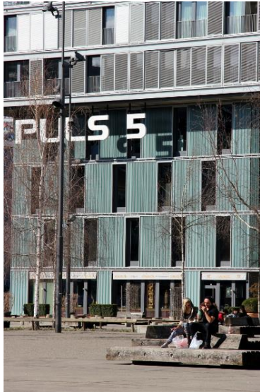
Abbildung 26: Puls 5 mit Eingang zur Giessereihalle
