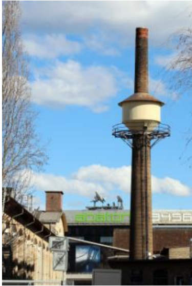
Abbildung 39: Nietturm (Hochkamin mit Wasserbehälter)
