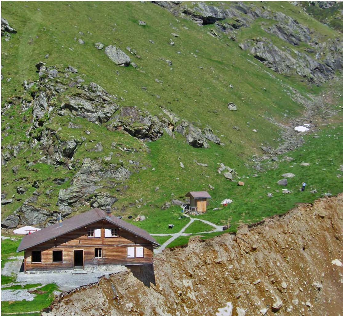
Abbildung 3.2: Von Rutschung betroffenes Gebäude in Grindelwald 1
