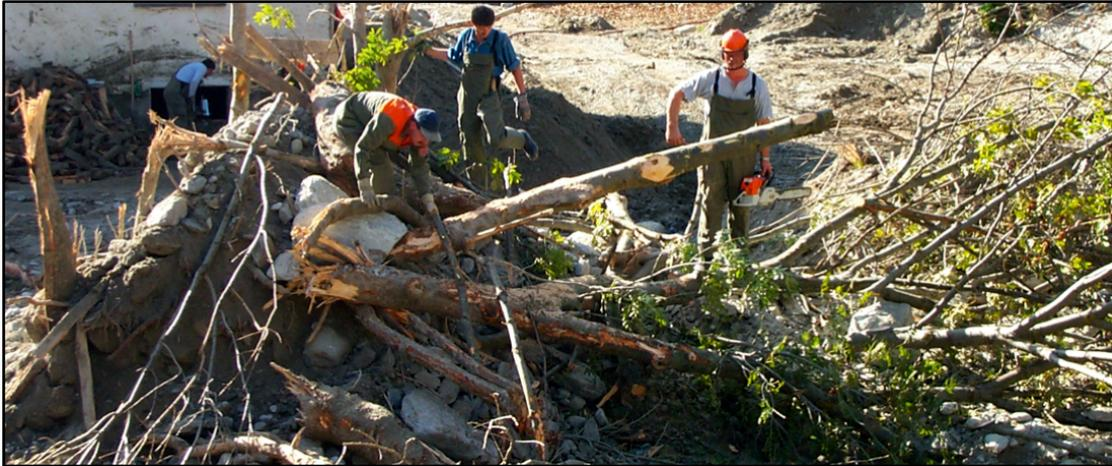
Abbildung 43: Während des Überschwemmungsereignisses in Baltschieder 2000 transportiertes und schliesslich abgelagertes Schwemmholz und Geschiebe, während der Aufräumarbeiten (Photograph unbekannt).
