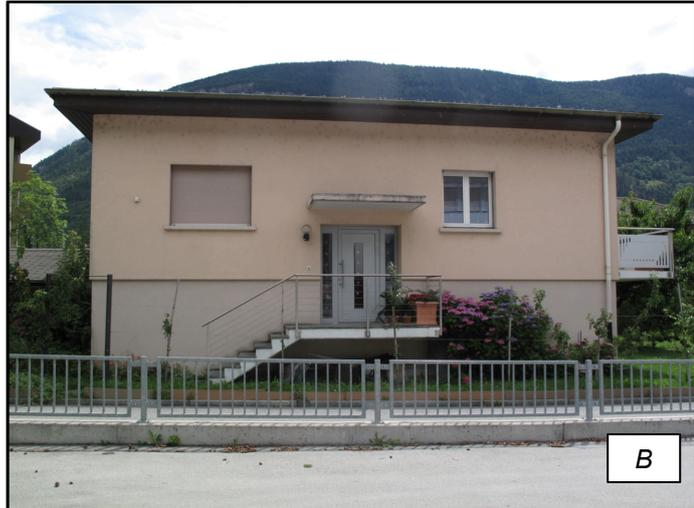
Abbildung 69: A: Angeströmte Fassade des Wohngebäudes Nr. 15. B: Angeströmte Fassade des Wohngebäudes Nr. 17 mit Stahlzaun auf Mauersockel im Vordergrund und der um 90 cm erhöhten Eingangstür.
