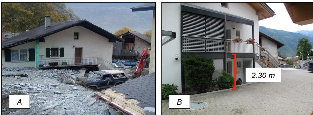
Abbildung 40: A: Kalibrierungsphoto eines Wohngebäudes (Photograph unbekannt). B: Bis heute bestehende Treppenlaube als Massstab für die Quantifizierung der Ablagerungshöhe.
