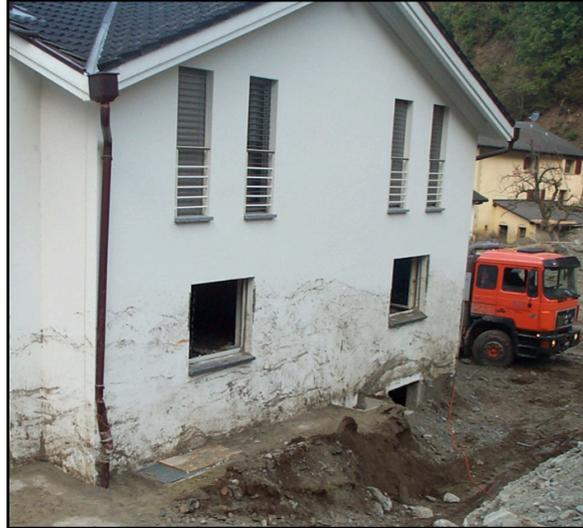
Abbildung 72: Photo von den Aufräumarbeiten mit Fliessspuren an der angeströmten Fassade, welche die maximale Wirkungshöhe markieren. Die Fenster in der oberen Etage wurden nicht erreicht und sind unversehrt (Photograph unbekannt).
