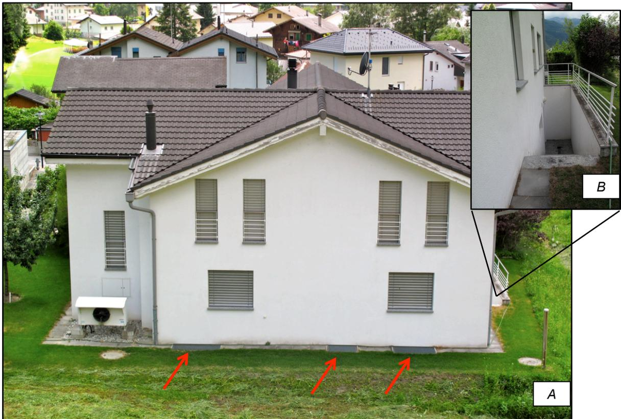
Abbildung 73 : A: Angeströmte Fassade des Wohngebäudes Nr. 1 mit Lüftungsschächten (rote Pfeile), Fenstern und B: einem seitlichem Eingang ins Untergeschoss.
