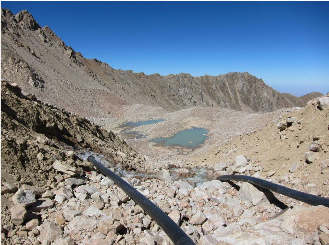
Anhang 7: Oberflächenabfluss vom See Sovetov zu den beiden Reliktseen im Seebecken des ehemaligen Gletschersees, der 1977 ausgebrochen ist. Im Oberflächenabflusskanal sind zwei Abflussröhren gelegt zur Seespiegelabsenkung. (eigene Aufnahme)
