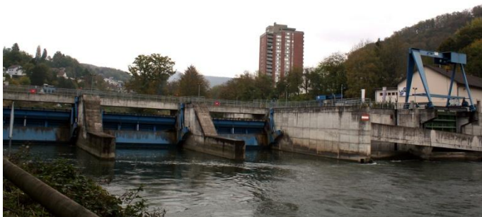
Abbildung 19: Flusskraftwerk Kappelerhof (Foto: S. HOSI 2014).
