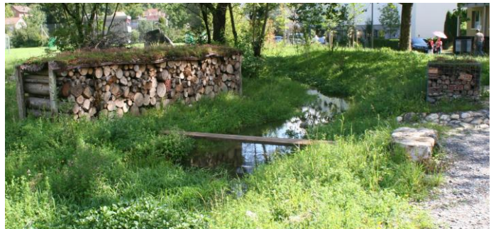
Abbildung 16: Freigelegter Bachabschnitt und Kleintierhotels vor dem Schulhaus Meierhof (Foto: S. HOSI 2014).
