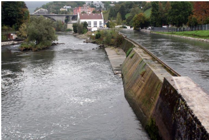
Abbildung 18: Blick von der Wehrbrücke auf das Kanalkraftwerk Aue (weisses Gebäude). Links der Mauer befindet sich die Restwasserstrecke, rechts davon der Oberwasserkanal (Foto: S. HOSI 2014).
