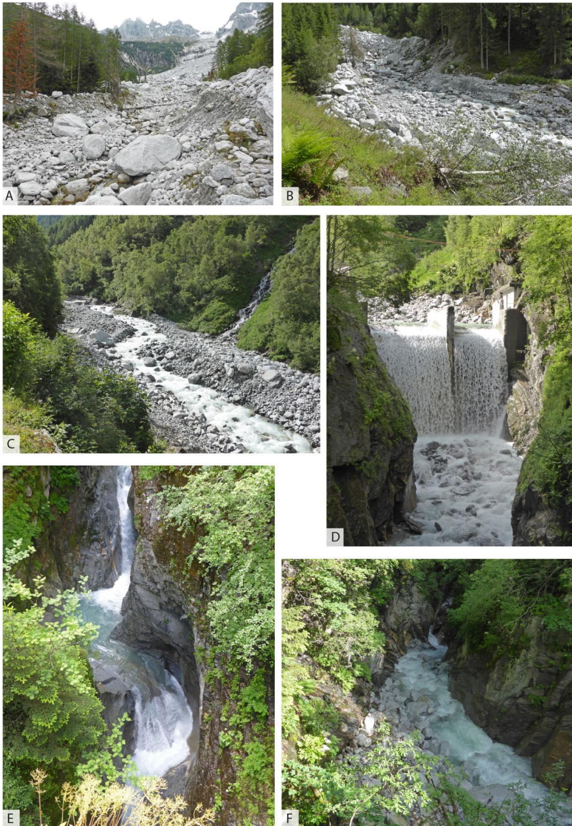
Abbildung 12: Morphologie der verschiedenen Gerinneabschnitte. A: Direkt unterhalb der Felssturzaflagerung. B: Eingangs Flachstück. C: Direkt vor der Staustufe. D: Die Staustufe. E – F: Schluchtabschnitt. Eigene Aufnahmen Juni und September 2014.
