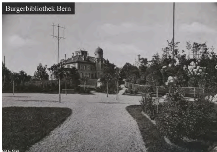
Abbildung 40: Blick gegen das physikalische Institut. Auf der rechten Seite ist die Erhöhung zu erkennen, welche Ende des 19. Jh. aufgeschüttet worden ist. (Burgerbibliothek Bern, FP.E.556)
