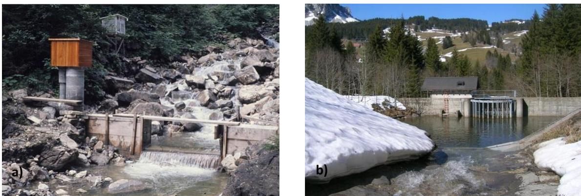
**Abbildung 2:** Ursprüngliche Abflussstation im Vogelbachgebiet von 1968 – 1974 (a) und neue Abflussmessstation im Erlenbachgebiet seit 1978 (b).
