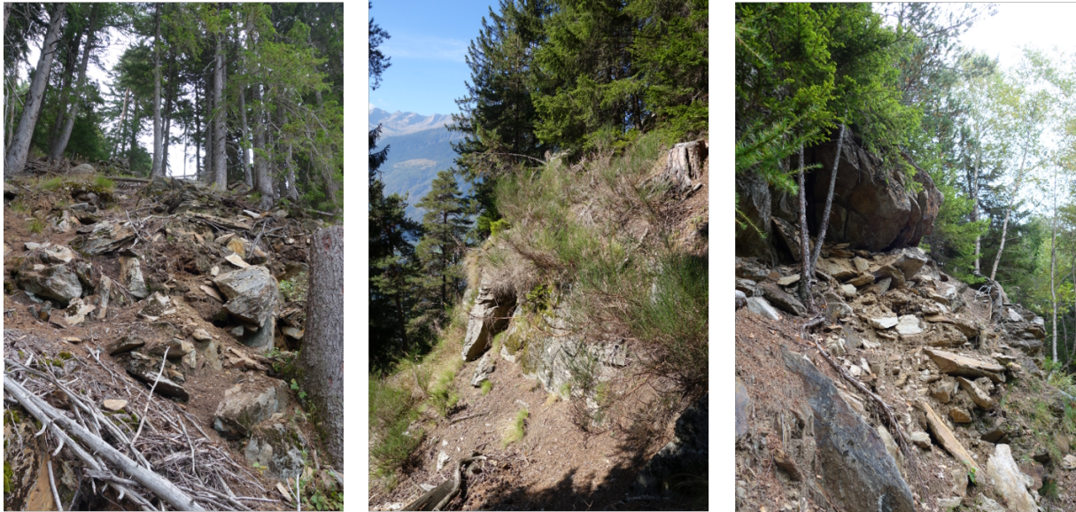
Abb. 20: Drei Beispiele von Anrissstellen im Untersuchungsgebiet.
