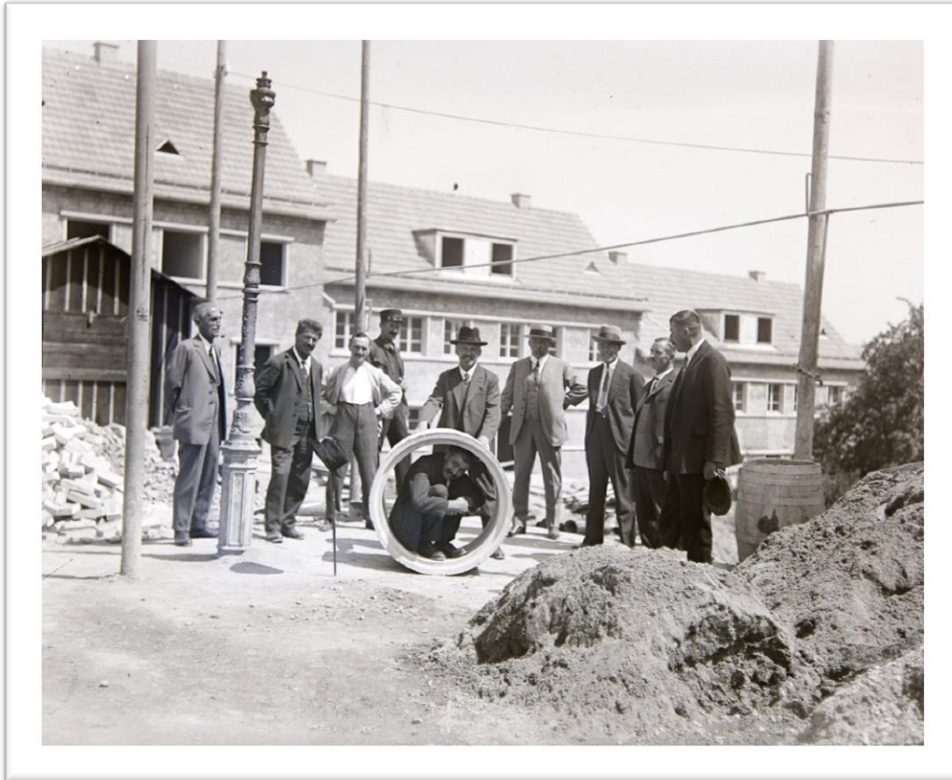
Abbildung 10: Vorstand bei der Besichtigung der Baustelle beim Entlisberg 2 in 1929 (Quelle: ABZ (2018))
