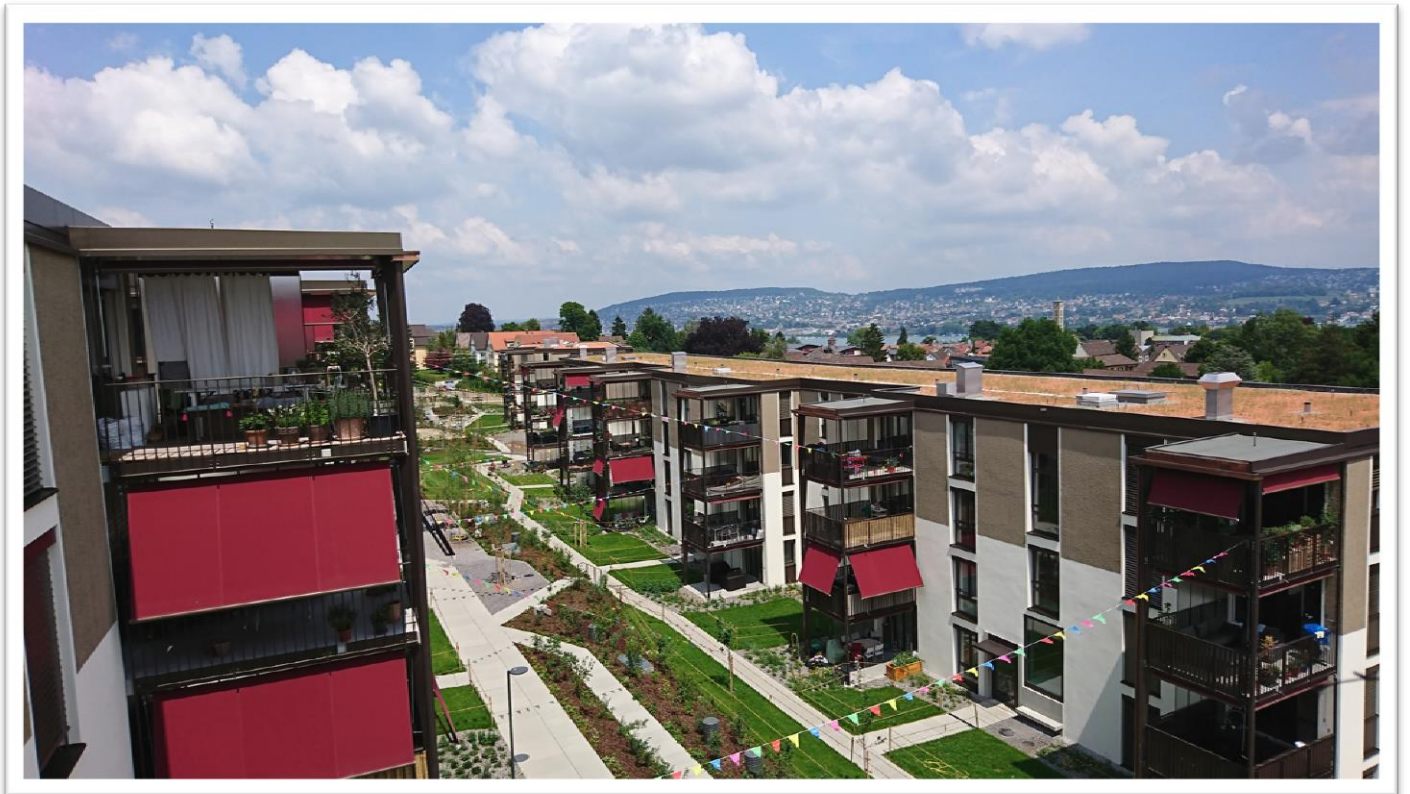
Abbildung 1: Ersatzneubau in Wollishofen, 2018, Bild vom Autor am 8. Juni 2018
