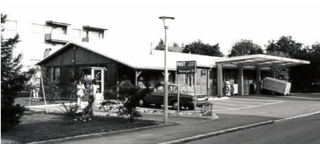
Abbildung 12: Poststelle Niederglatt in einer provisorischen Baracke (Standort der Post 1975–1989) im Jahr 1977
