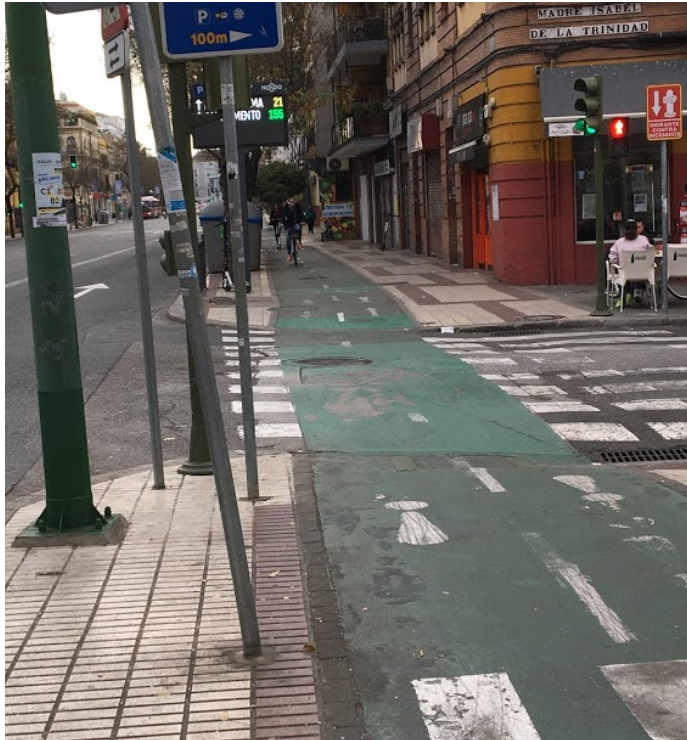
Abbildung A-4: Zweispuriger Veloweg auf Trottoir in Sevilla, Spanien (eigenes Bild, 8.2.2020)
