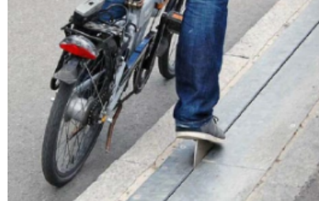
Abbildung A-8: Trittstufe des Trampe Cyclocables in Trondheim, Norwegen (Matias & Virtudes, 2019, S. 6)
