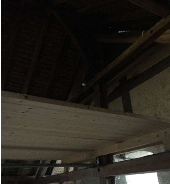
Dachstock Kirche, Wochenstube Fledermäuse
