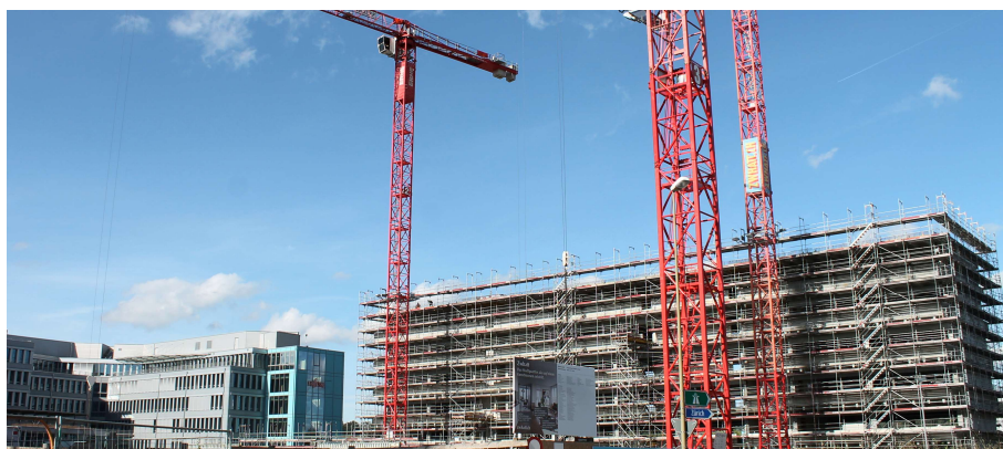
Abb. 37: Aktueller Baufortschritt Zwhatt-Areal. Gewerbebau. Eigenes Foto vom 19.09.2023
